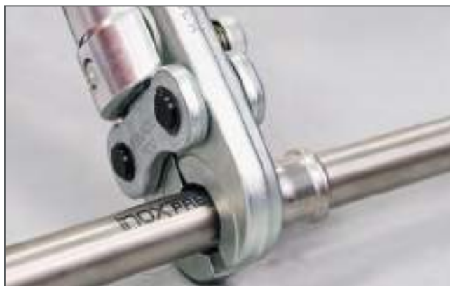
Assemblaggio attraverso pressatura / Making the press connection
