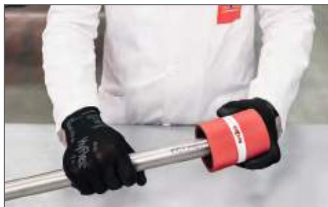
Sbavatura del tubo / Deburring the pipe
