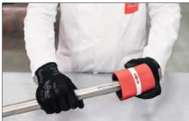
Sbavatura del tubo / Deburring the pipe
